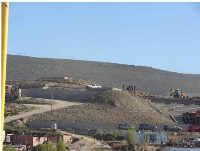
Fig. 1. Equipo de trabajo de PROMEBA, edificando “El Morro”
